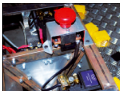
Il pulsante di stop per togliere tensione in caso di emergenza.
