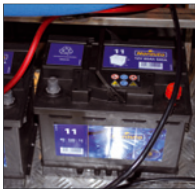
Le batterie attualmente sono quelle per l'avviamento degli autoveicoli.
