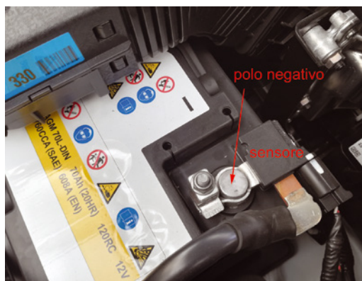
Fig. 5 Batteria auto con applicato il sensore di corrente.
