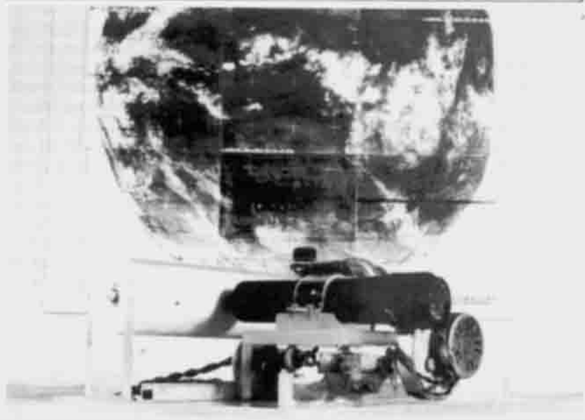
Fig. 12 - Nello sfondo il disco terrestre (ME-TEOSAT IR) riprodotto con il fax in primo piano. È un riproduttore a carta fotografica di costruzione amatoriale.
