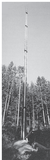
L'antenna telescopica utilizzata negli impianti della rete svizzera d'emergenza IBBK
