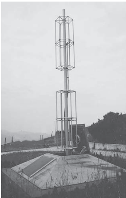
L'antenna telescopica utilizzata negli impianti della rete svizzera d'emergenza IBBK
