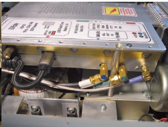
Modifica contenitore SDR con inserimento relè e connessioni per analizzatore di spettro
