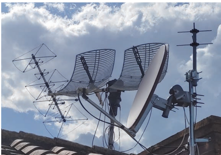
L'attuale impianto di ricezione in banda L e S e alcune altre antenne
