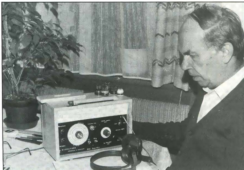
Fig. 5 - L'autore dinanzi al ricevitore terminato; sono visibili le cuffie, le bobine e l'apertura superiore nel contenitore ove vanno innestate le bobine.
