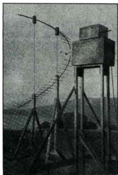
A sinistra una foto scattata nel novembre del 1931 a Santa Margherita Ligure. Accanto a Marconi il collaboratore ing. Mathieu presso l'antenna parabolica per il ponte ad onde ultracorte per il contatto con Levante. A destra, la stazione ricevente.
