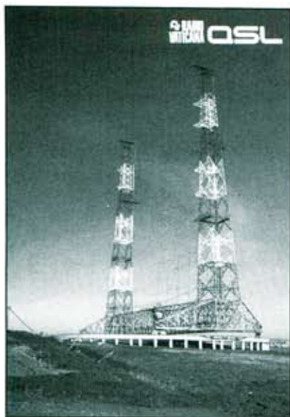
La nuova antenna trasmittente rotante alta 106 m installata nel 1988 nel centro trasmittente di S. Maria di Galeria.
