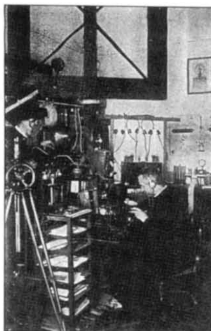
Fig. 1 - Stazione radiotelegrafica dell'Osservatorio di Montecassino per lo studio dell'elettricità atmosferica e dei temporali
