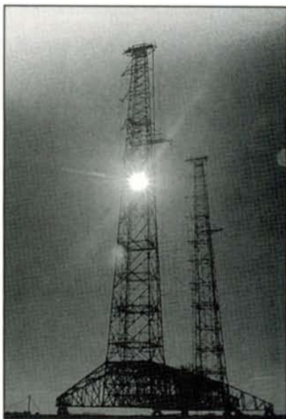
Fig. 4 - Antenna trasmittente rotante alta 106 m installata nel 1988 nel centro trasmissente di S. Maria di Galeria
