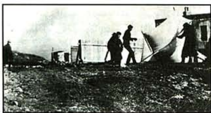
St. John - Terranova: i collaboratori di Marconi (presente nella sinistra della foto) innalzano il "cervo volante" che sosterrà l'antenna verticale (alta circa 120 m), per le prove di ricezione della stazione di Poldhu
