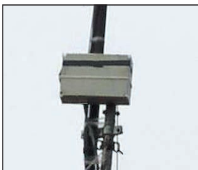
Foto 2 - Particolare dell'antenna montata sul tetto
