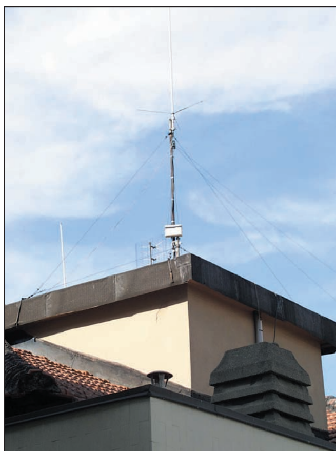
Foto 1 - L'antenna montata, sotto la bibanda V/UHF
