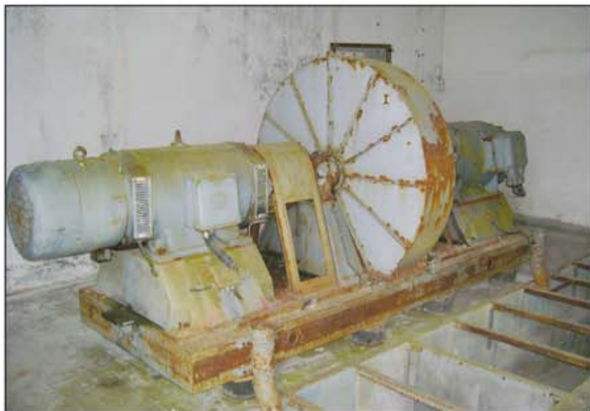
Il vecchio gruppo di continuità inerziale con dinamo tachimetrica.
