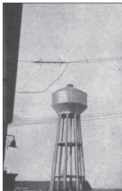
Serbatoio idraulico da 60 ton e isolatore di ritenuta della coda
