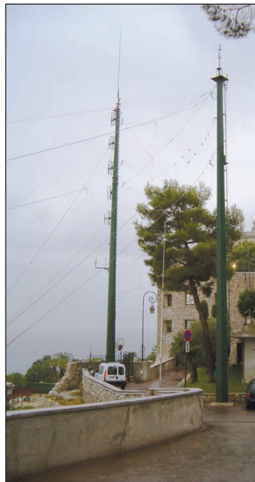
La piccola struttura che ospita 3AC nonché il sistema d'antenna per le onde corte e VHF
