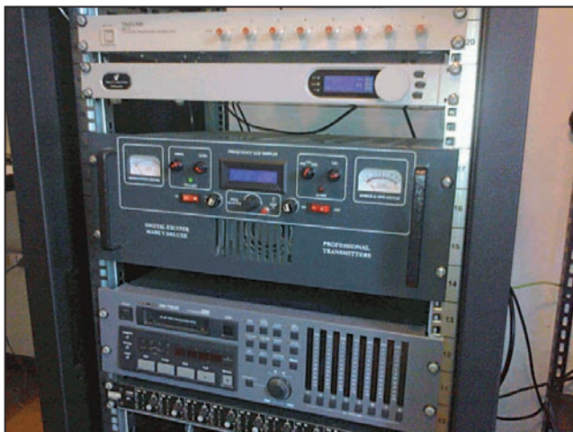
Il trasmettitore in AM e le apparecchiature di supporto alla trasmissione.
