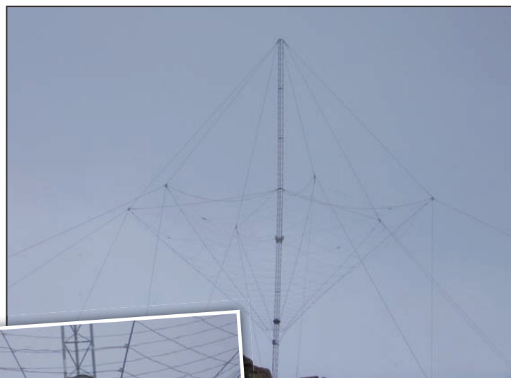
Antenna omnidirezionale Spidercone per le frequenze utility HF. Foto di IK5DHM
