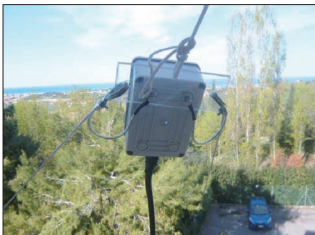
Fig. 9 - Antenna OFDC: particolare Balun
