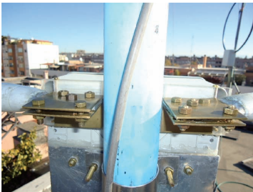
Fig. 19 - Fissaggio delle flange con le armature e rinforzi di ottone.
