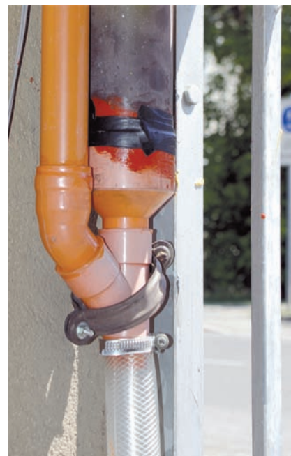
Fig. 6 - Dettaglio dell'Y per tubo di sicurezza.
