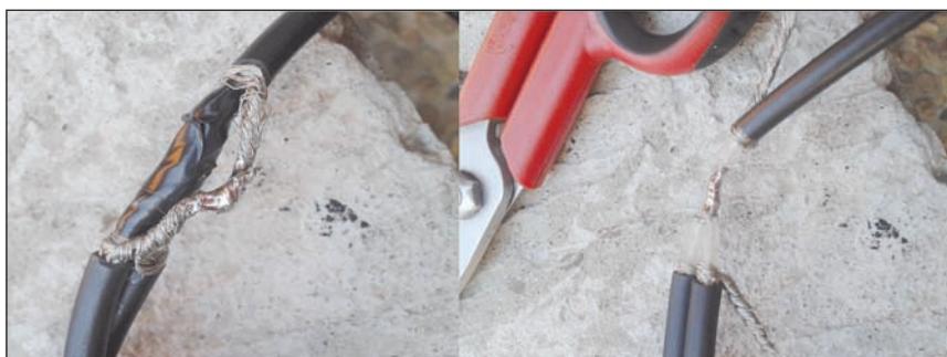
Fig. 3 - Collegamento adattatore di impedenza
