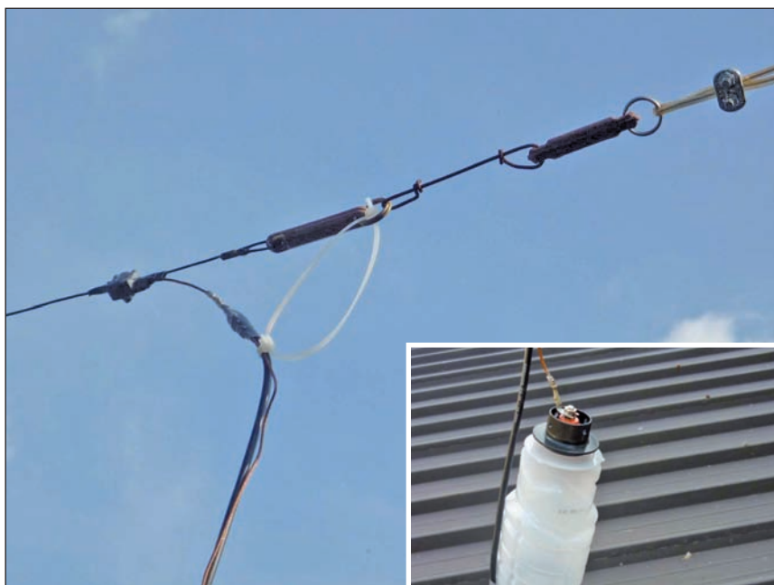
Foto 3 - Alimentazione antenna con cavo RG 58
