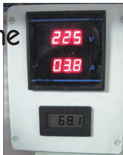
Il circuito in opera
