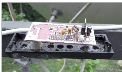
Fig. 9 - In fase d'installazione
