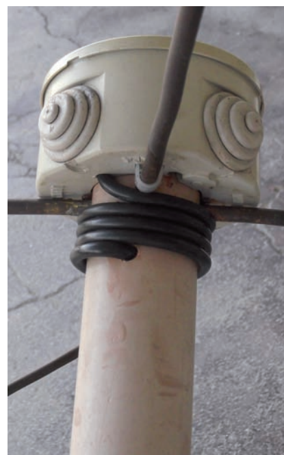
Fig. 7 - Realizzazione del balun, immediatamente sotto la scatola
