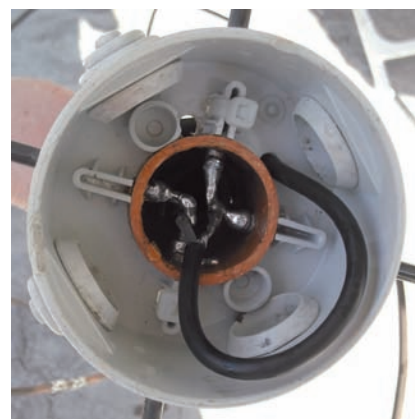
Fig. 6 - Collegamenti relativi ai due bracci dell'antenna e al cavo RG 58
