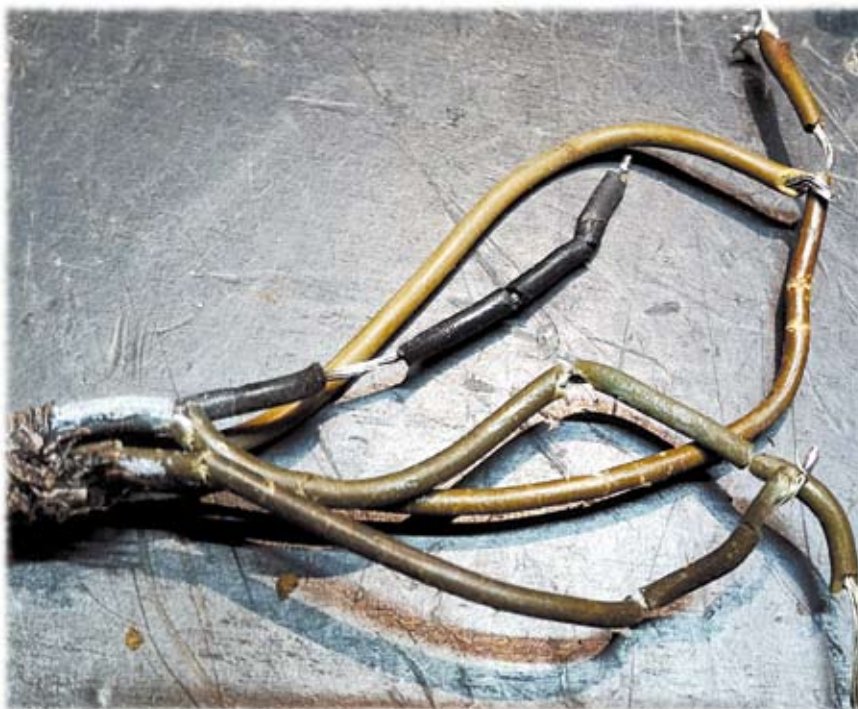
Fig. 5 - Esempio dei cavi interni con l'isolante rovinato. Purtroppo il trascorrere del tempo si vede molto in questi materiali
