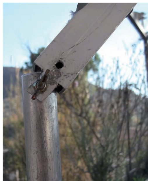
Fig. 4 - Il sistema di snodo per regolare l'inclinazione
