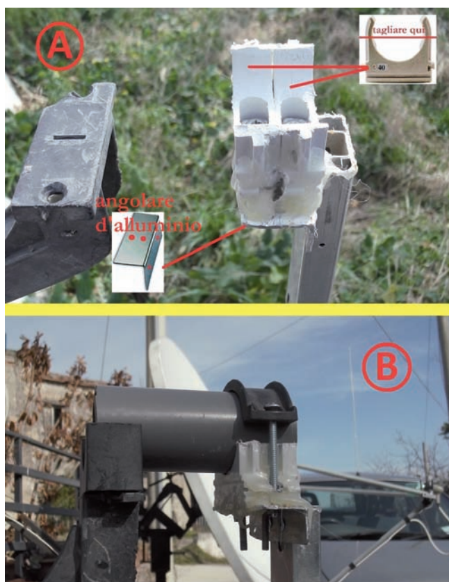
Fig. 5 - il nuovo supporto ultimato
