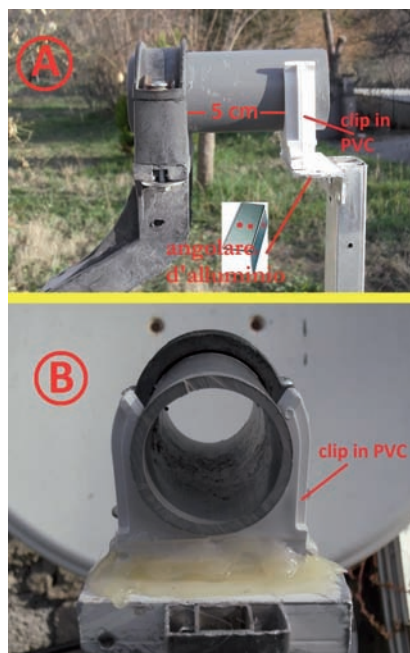
Fig. 4 - Allineamento dei due supporti.
