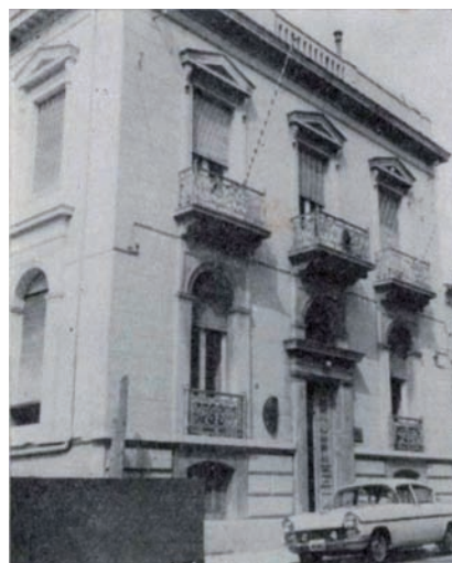
Fig. 6. - Bouboulinas str. Pireo. Sede SAIT poi Cherma dal 1938. Foto anni '50 (SAIT Electr. Digest. 2.1966)
