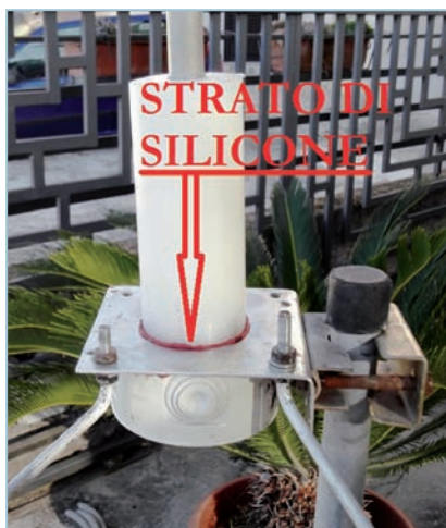
Fig. 11 - L'antenna in fase di montaggio
