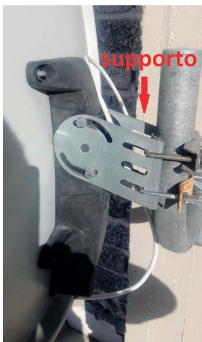
Fig. 2 - Tipo di supporto che consente l'orientamento, senza alcun accorgimento particolare.
