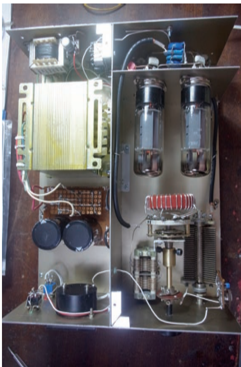
Il lavoro è quasi finito: si vedono i vari moduli e quasi tutte le connessioni.
