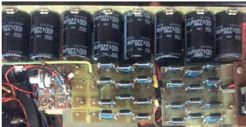
Dettaglio alimentazione anodica
