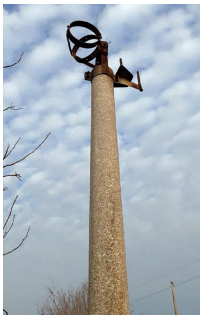
Uno dei piloni "bassi" che probabilmente era il supporto dei cavi di alimentazioni delle antenne.
