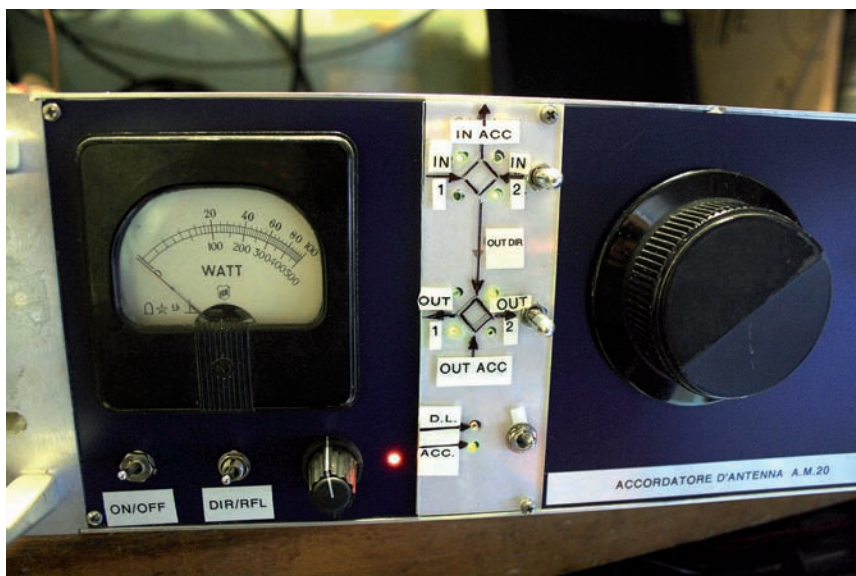
Foto 7 - Particolare pannello anteriore con quadro comandi
