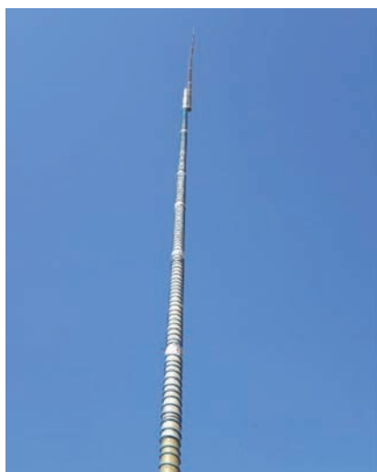
Fig. 7 - Antenna elicoidale.
