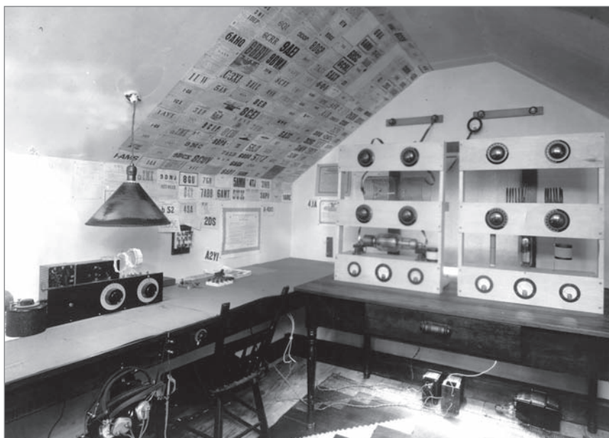
Foto 2 - Stazione di Collins
