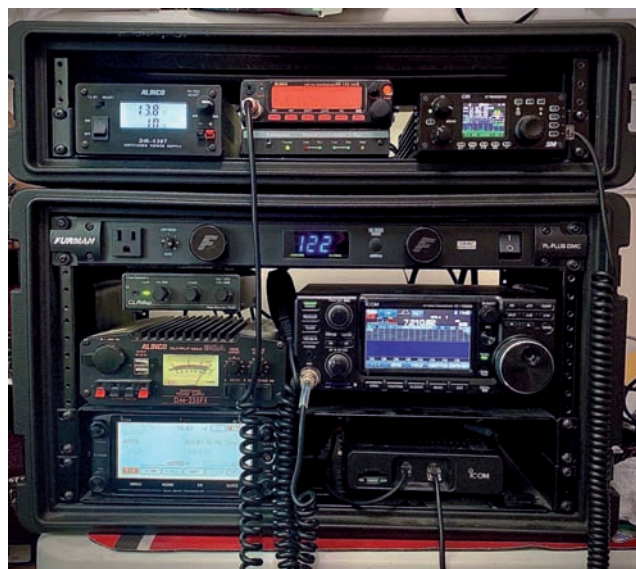
Fig. 1 - Esempio di valigetta radio di tipo radioamatoriale. Queste valigette, costruite artigianalmente, contengono tutto il necessario per impiantare una stazione radio in VHF/UHF e onde corte.
