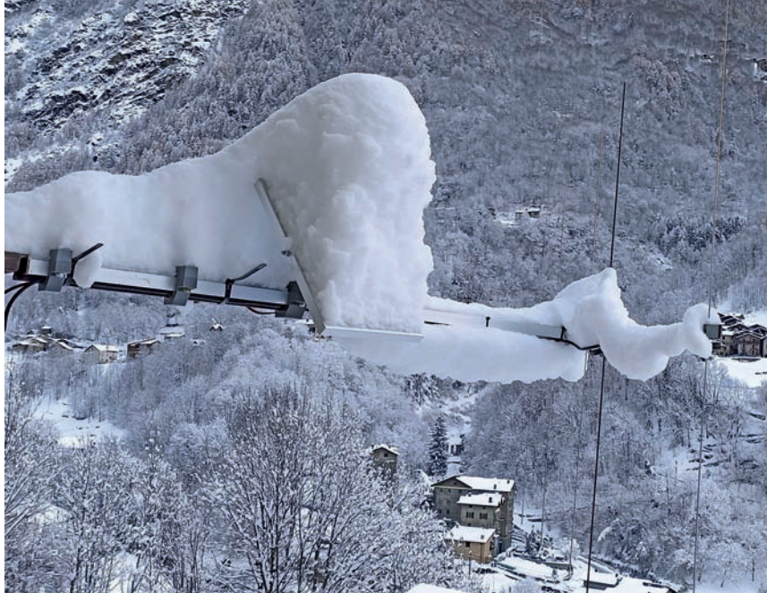
Fig. 6 - In montagna i pannelli solari hanno vita dura. Sotto la neve diventano del tutto inutilizzabili.
