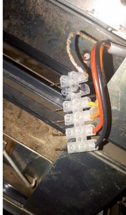
Morsettiera a pettine sdentato che si affianca a quella dell'alimentatore.
