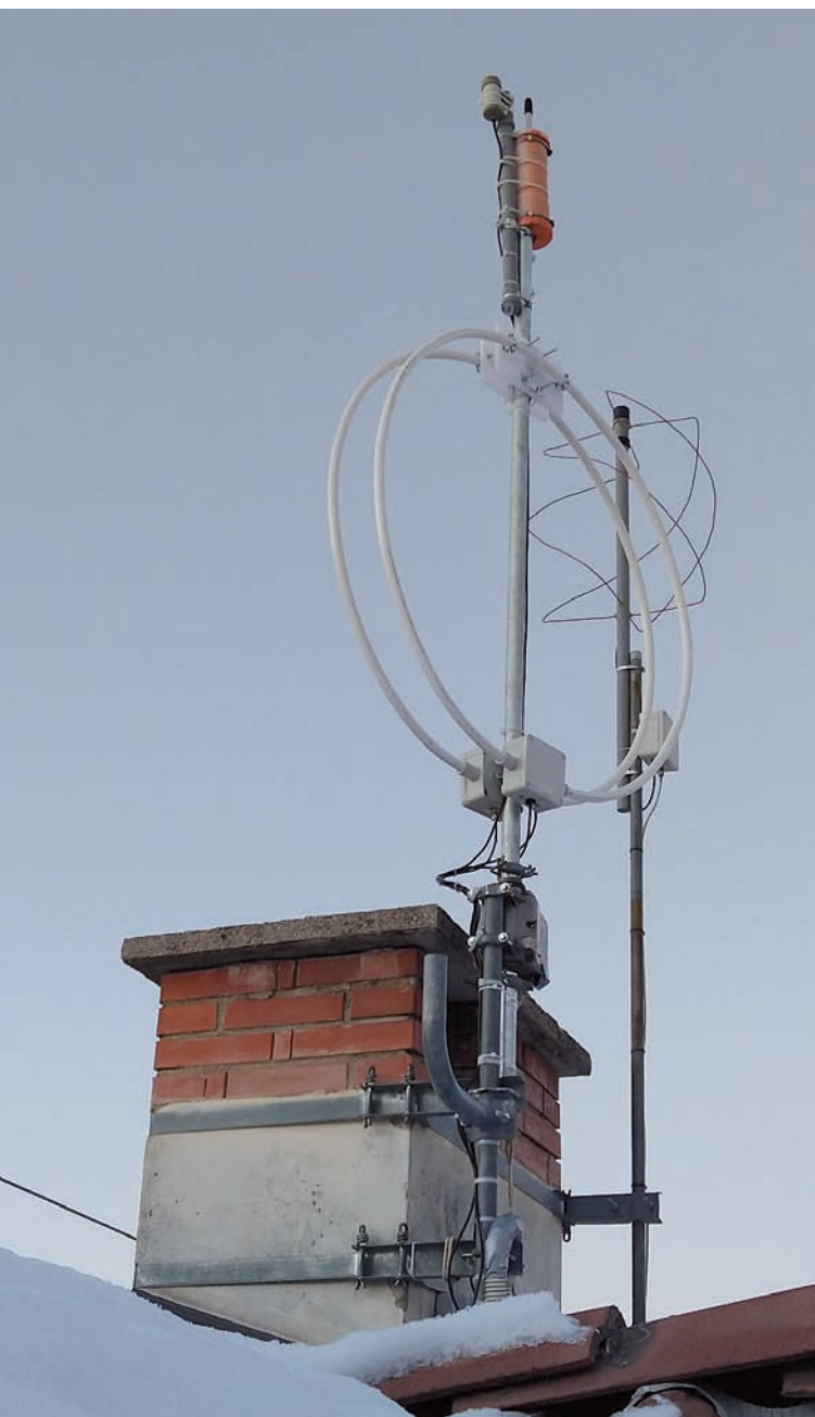
Figura 1 - Rotore installato
