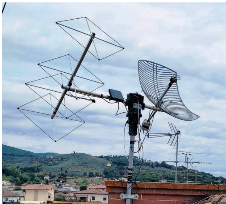
Foto 9 - Attuale installazione su rotore Yaesu G-5500, da destra cubical quad VHF, antenna patch per satelliti Inmarsat 1.5 GHz e Parabola wifi a griglia per Satelliti HRPT a 1.7 GHz
