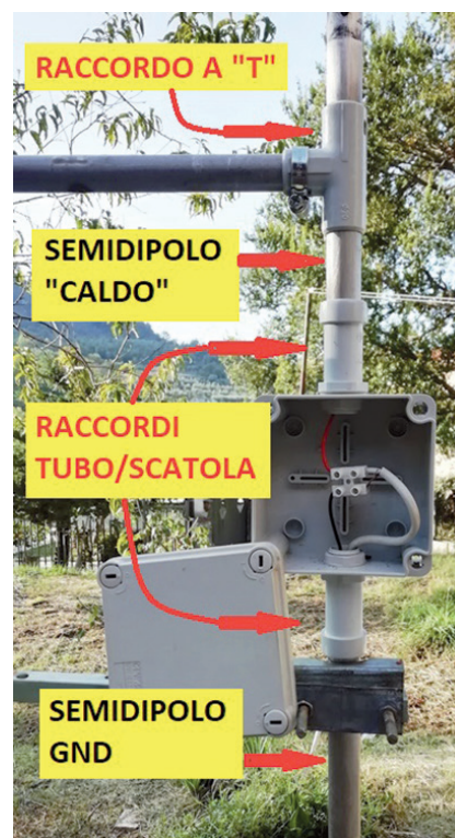
Fig. 14 - Montaggio dei tre raccordi in PVC
