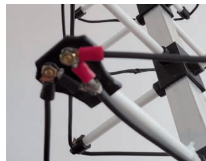
Foto 6 - Particolare del punto di alimentazione tra radiatore e cavo coassiale
