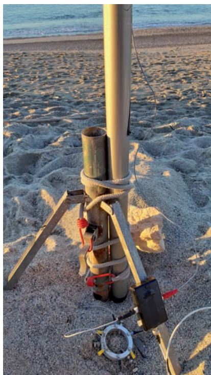
Particolare dell'antenna con il BalUn 36:1 e il sistema di posa e fissaggio
