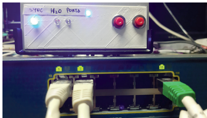
Foto 3 - Il telecomando in opera
