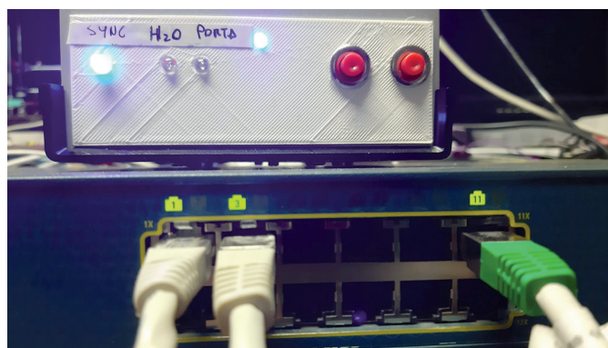
Foto 3 - Il telecomando in opera
