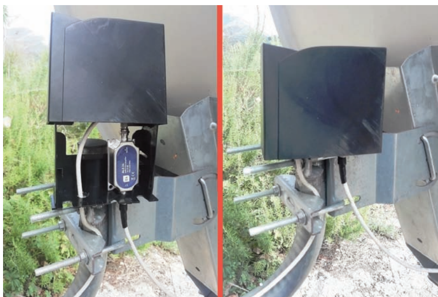
Fig. 14 - L'amplificatore sistemato dietro la parabola
