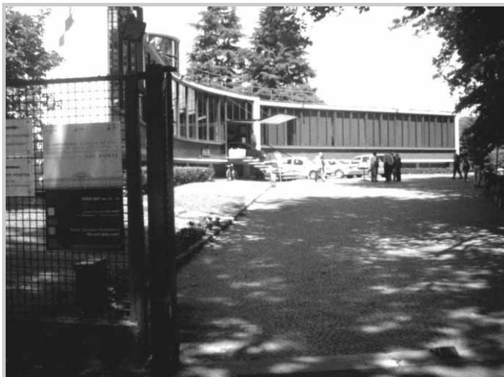
Una visuale dal cancello di ingresso alla palazzina del Centro di Controllo Raiway, progettata da Giò Ponti.
