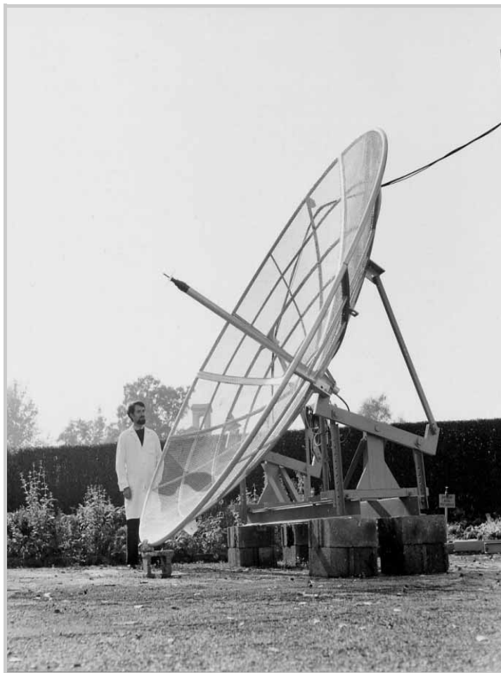
L'antenna per la banda satellitare C utilizzata per le prime prove di ricezione di satelliti geostazionari a Monza.
