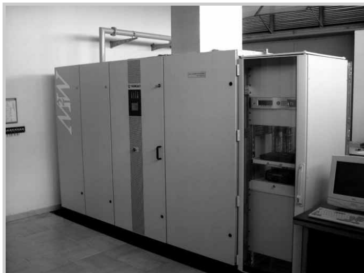
Il trasmettitore Thomcast Thales di Radio Vaticana sui 1611 kHz.
