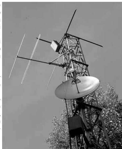
Piccolo ripetitore RAI collocato a Loch di Pulfero (UD). Particolare antenna Yagi per le trasmissioni di RAI UNO sul canale B in orizzontale.
