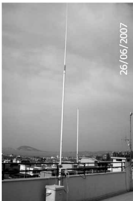
L'antenna completa sul mio terrazzo (con accanto la X300 per le bande V-Uhf).
