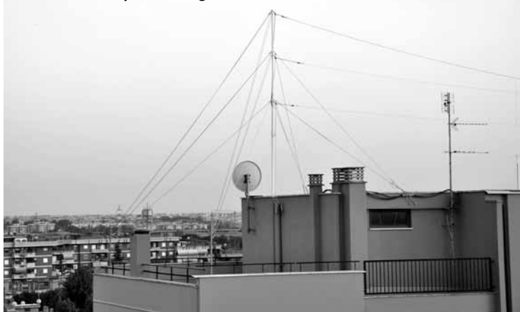
Particolare palo sostegno e tiranti
