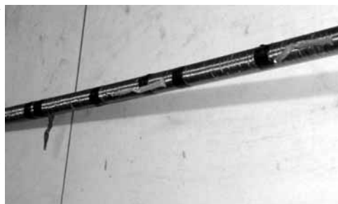
Foto 2 - Particolare di alcune prese da portare successivamente nella scatola alla base del tubo.
