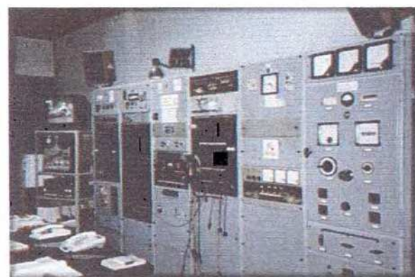
"armadi" di trasmissione
